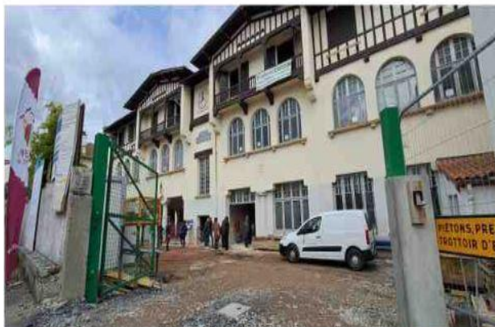
Cette réhabilitation est prévue sur dix-huit mois, sans modification de la façade de l'édifice néo-basque. V. D.
