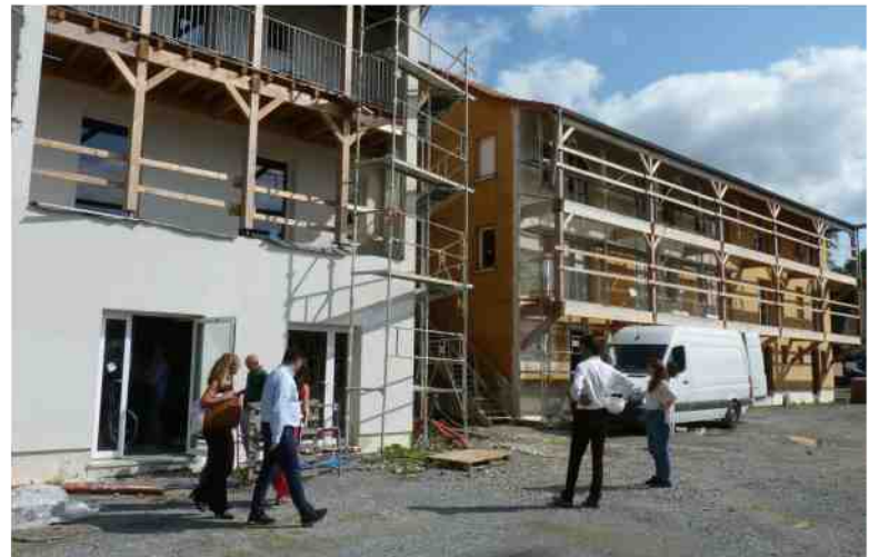
Les architectes Hugues Joinau et Jany Lessire (à droite sur la photo) ont fait visiter le chantier de la résidence. Dominique Fillieux
