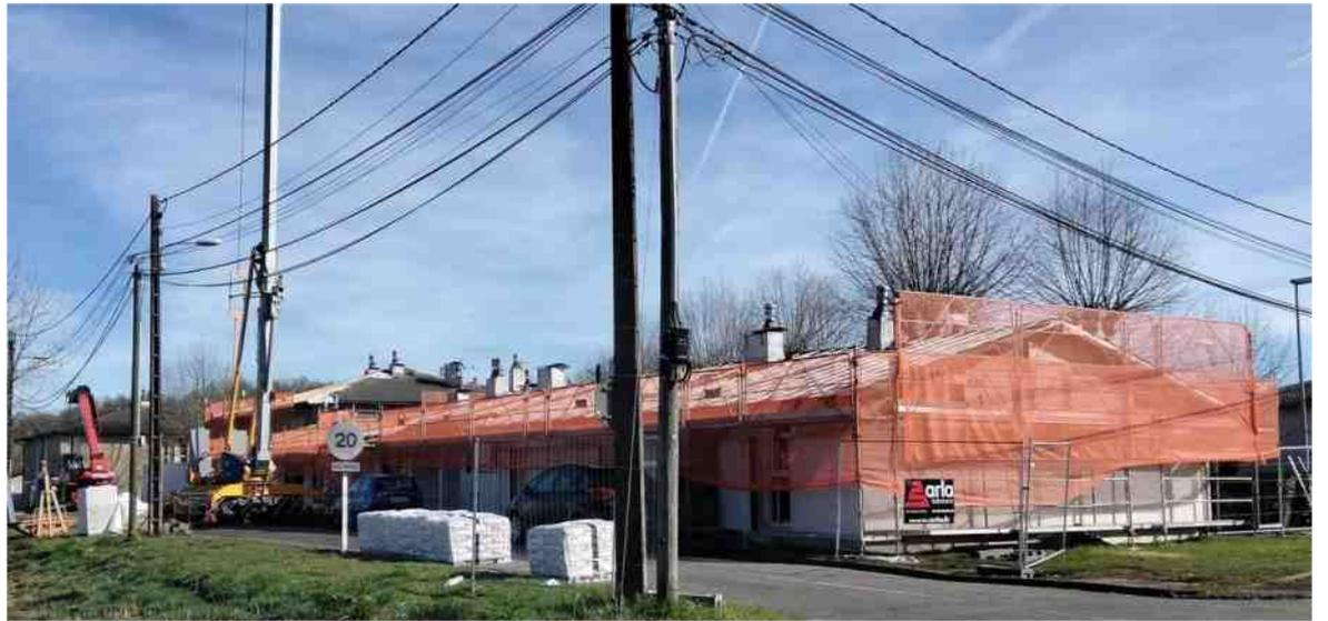
Le désamiantage, l'isolation des combles et des façades, la rénovation des toitures sont en cours. Pierre Grazide
